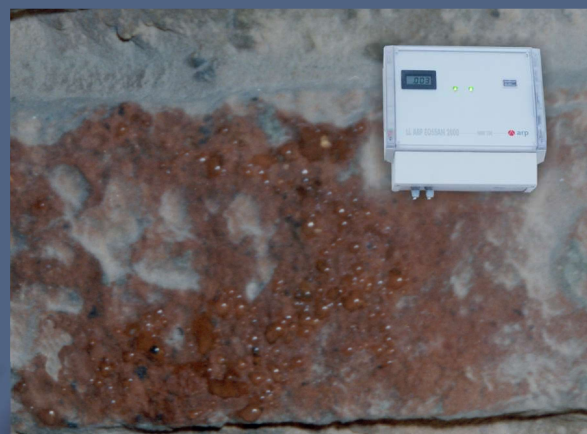
Zid 8 dana nakon uključjenja sustava u proces sušenja. Kod izuzetno vlažnih zidova (>20%) moguća je pojava kapljica vode na površini zidova.
