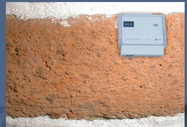
Osušeni zid nakon perioda od 6-36 mjeseci, ovisno o količini vlage u zidu ( \% = ST:H_2O )
